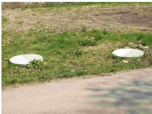
Takový je pohled na nádrže dnes
